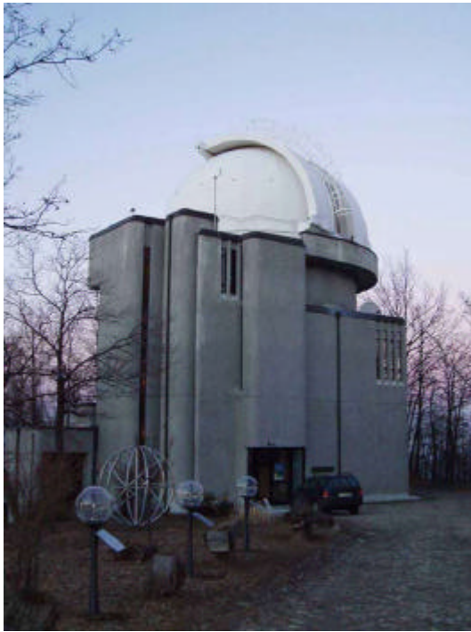
L'edificio che accoglie il telescopio Cassini di 1,5m
